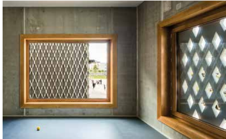
▲ Bâtiment passif oblige, les menuiseries en mélèze (Menuiserie Moreau) qui offrent de larges vues sont dotées de triples vitrages.
