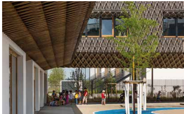
▲ Dans la cour, la résille bois se retourne pour former une grande marquise. Laquelle est maintenue par un système de poutres-échelles.
